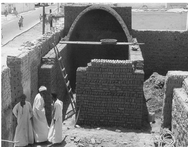
図19 古代構法によるヴォールト屋根の建設 アスワーン西岸のヌビア人村
