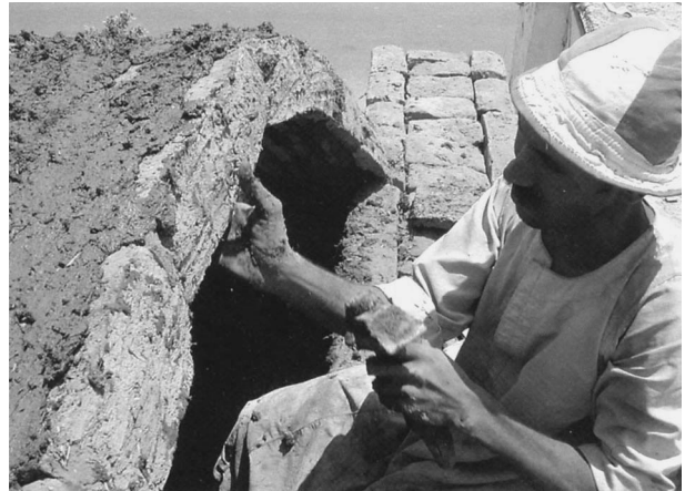
図21 古代構法によるヴォールト屋根の建設 手斧を片手に持って煉瓦を設置する様子
