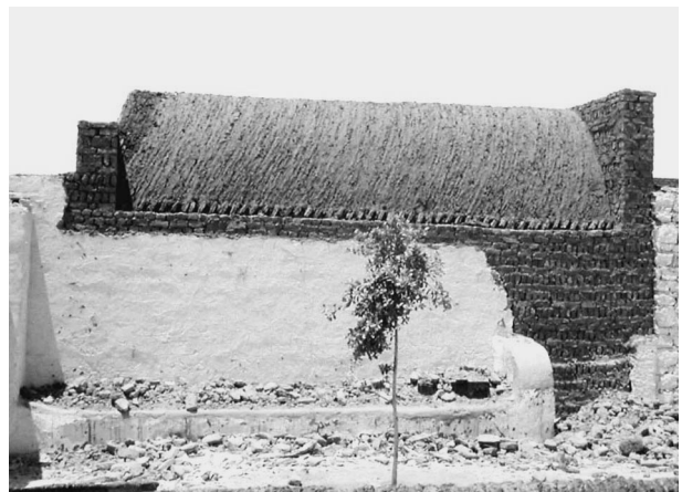
図22 古代構法によるヴォールト屋根の建設 完成されたヴォールト屋根
