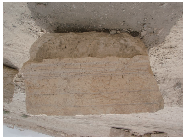
図30 窗枠下部 (南面柱間中央・内部)
