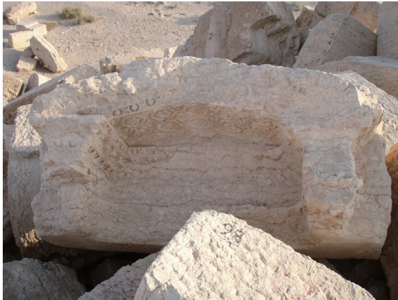
図20 窓枠上部 (柱間中央)
