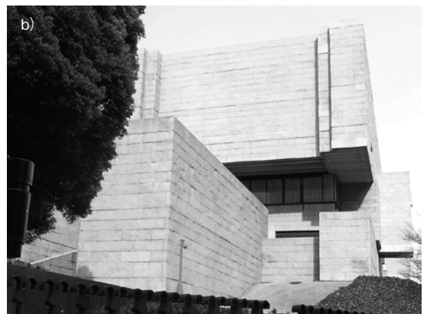
図6. 稲田石が使われた首都圏の歴史的建造物 a) 三井本館 (1929竣工)。b) 最高裁判所 (1974竣工)。
