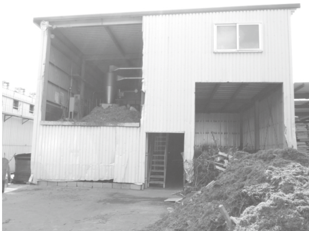
写真3 木くず炊きボイラー（製材所O1）
