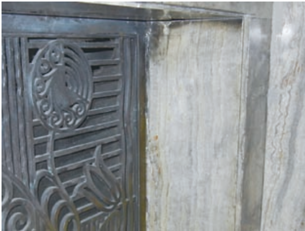
図 21. 大客室の暖炉（図20）の内側。正面に見えている石材の小口断面にあたる。正面には見えていない縞模様から、大理石の中でも「オニックス」と呼ばれる種類の石材に近いことが分かる。富山県のオニックスに類似の色目のものがあつたことが知られている。
