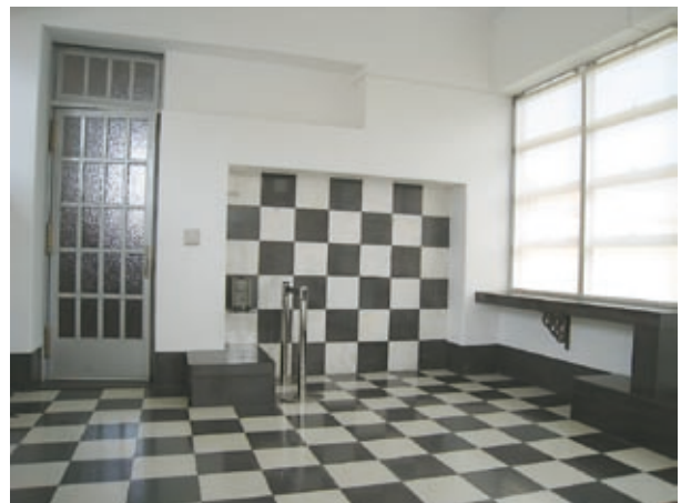
図9. 三階ウィンターガーデン。床は人造石であるが、壁の市松模様は大理石である。
