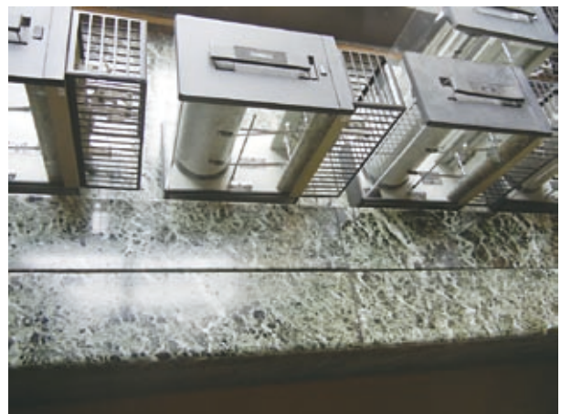
図19. 二階の北の間(第二ベランダ)の窓台。図14と同じ理由で国産の蛇紋岩である可能性が高い。
