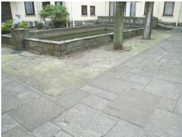
図3. 中庭。周縁部と中央部とはいずれも鉄平石が用いられているが、敷き方のパターンを変えている。
