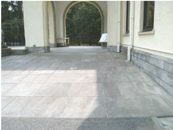
図2. 入口車寄せ付近。敷石と建物腰壁に安山岩石材が用いられている。
