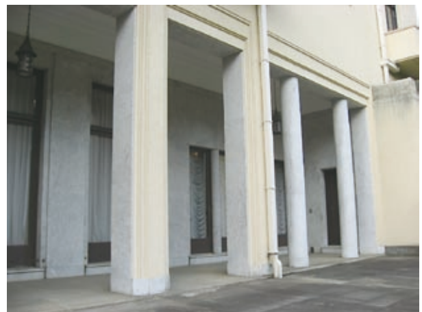
図15. 正面テラス。柱と外壁に大理石が用いられており、パターンが図5および12の国産大理石によく似ている。テラス部の敷石には花崗岩が用いられ、それより外側は安山岩石材が敷かれている。
