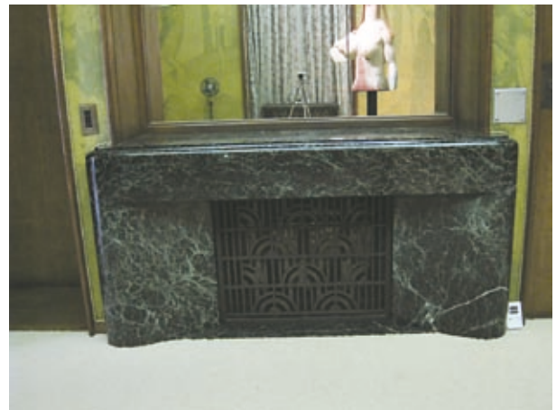
図14. 小客室の暖炉。アンリ・ラパンが内装設計を担当した部屋で、石材の記録はない。当時すでに埼玉県秩父で、色柄も世界に引けを取らない蛇紋岩石材が採掘されていたことを考慮すると、国産の「蛇紋」である可能性がある。
