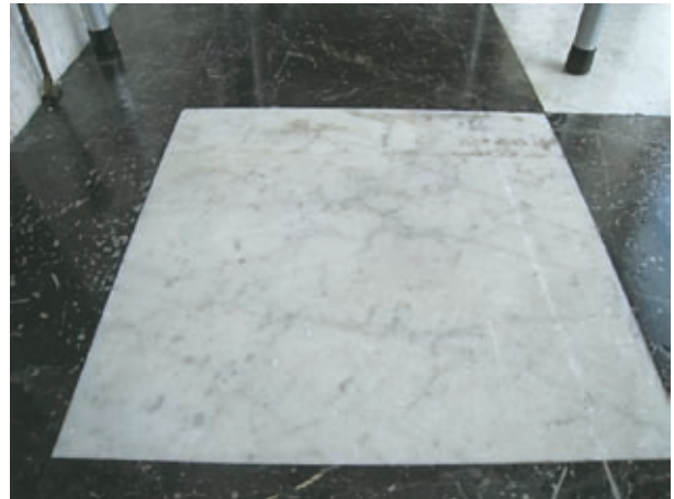
図8. 二階表ベランダの床市松模様。記録上は国産としかないが、淡灰色の紋様のパターンから、当時も輸入されていたイタリアの「ピアノ・カラーラ」の可能性が高い。
