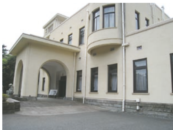
図1. 東京都庭園美術館（旧朝香宮邸）建物外観。
