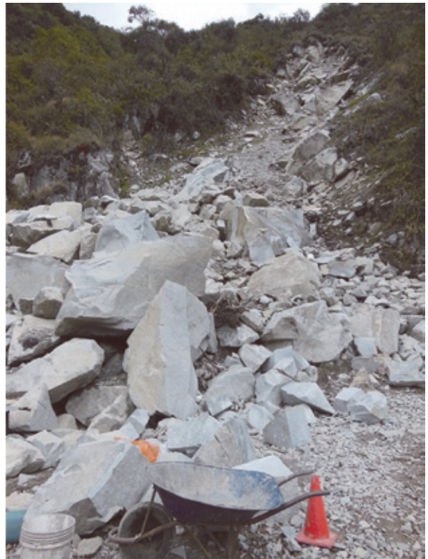
写真-23 斜面崩壊
