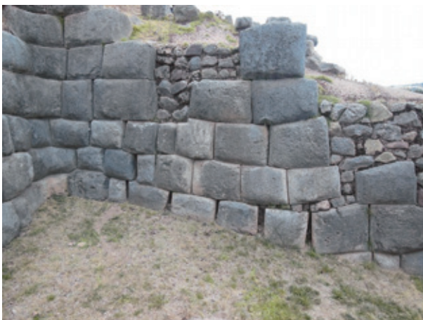
写真-21 サクサイワマン遺跡の地盤沈下
