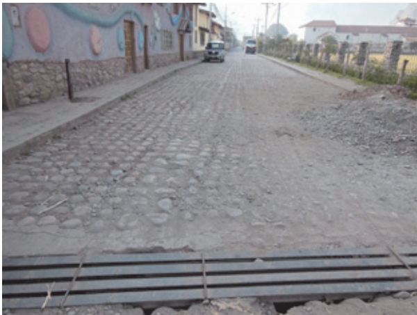
写真-9 石詰めによる路盤施工
