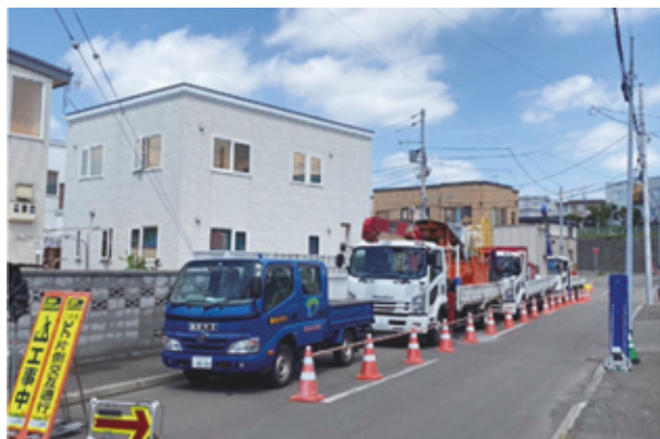
写真-7 現場状況（車上プラント）
