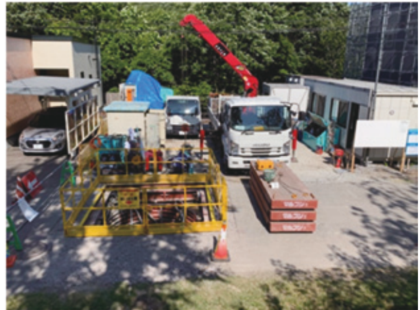
写真-9 現場状況
