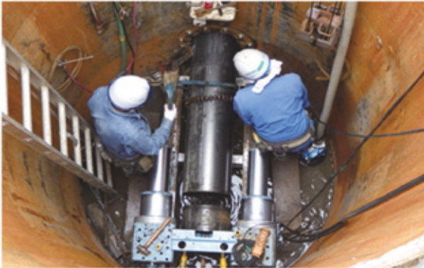
写真-6 推進用鋼管引抜き
