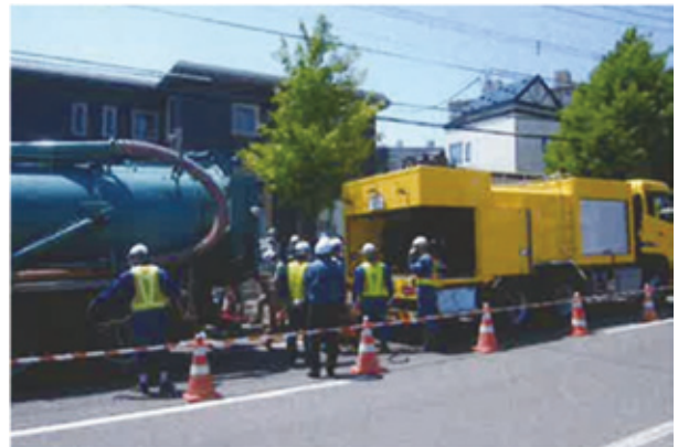
写真-12 洗浄状況（美しが丘地区）
