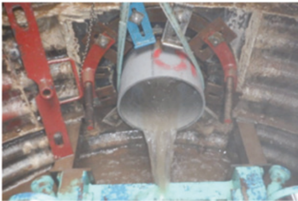
写真-11 施工完了（排水状況）
