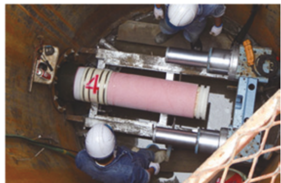
写真-5 MPDパイプ挿入
