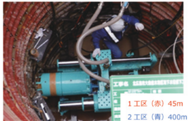
写真-10 施工状況
