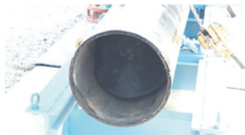
写真-4 掘進機格納完了
