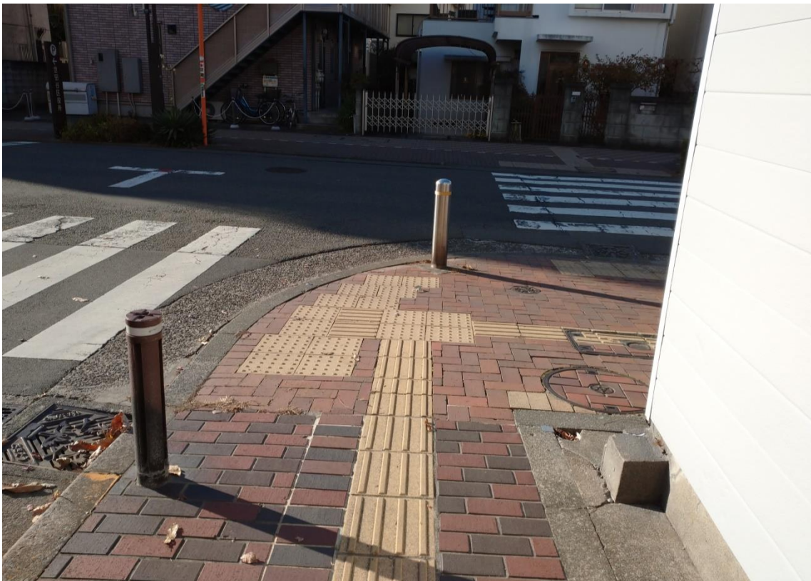
図-34 極めて見通しの悪い曲がり角 (⑭地点)
