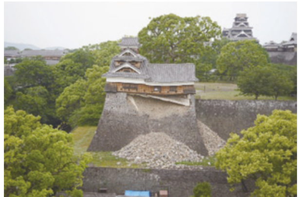
図-21 石垣崩壊の様子
