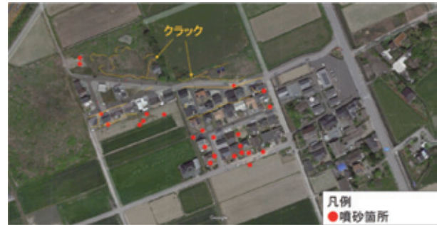
写真-2 芝原団地の噴砂及び地割れ (クラック) 状況
