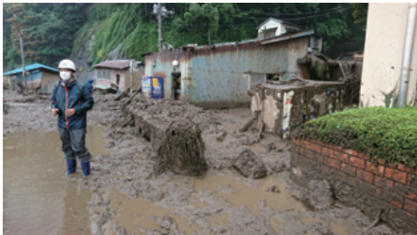
写真-7 土石流による最下流橋梁周辺の土砂堆積状況
