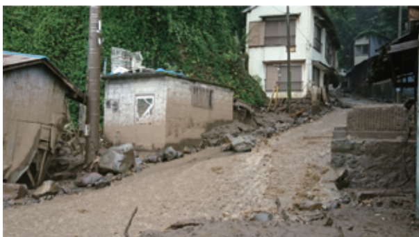
写真-9 最下流の道路が河川となっている状況
