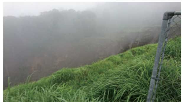
写真-3 土石流源頭部盛土崩壊の状況
