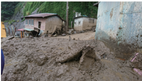
写真-8 土石流による最下流の土砂堆積状況
