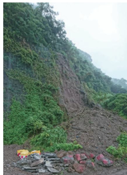
写真-11 有料道路脇の土石流による産業廃棄物の土砂堆積状況
