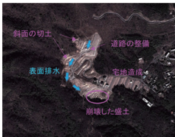
写真-15 土石流源頭部上流開発に伴う表面排水 5)
