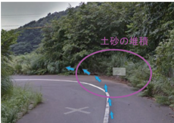
写真-17 土石流源頭部上流道路からの盛土内への流入 7)
