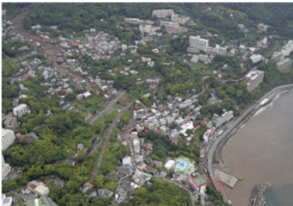
写真-1 熱海市伊豆山地区において発生した土石流被害状況 1)
