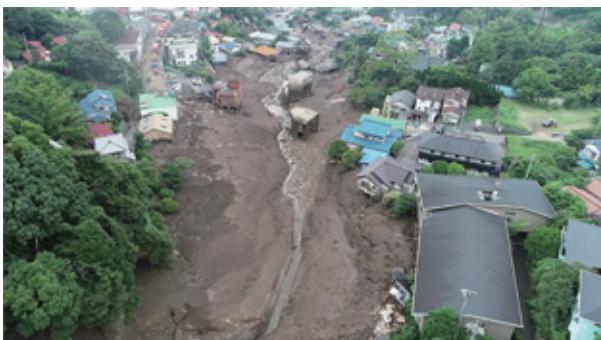
写真-2 土石流による家屋被害状況(国土地理院提供) 1)
