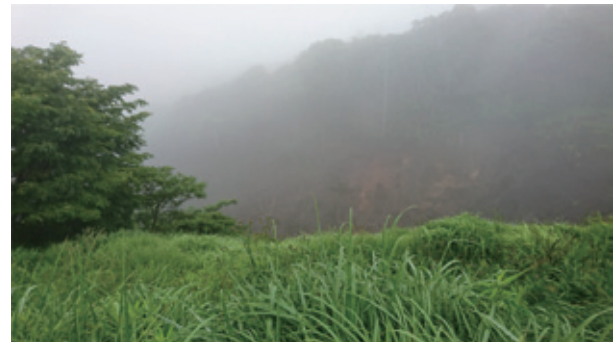
写真-4 土石流源頭部盛土崩壊下流の状況
