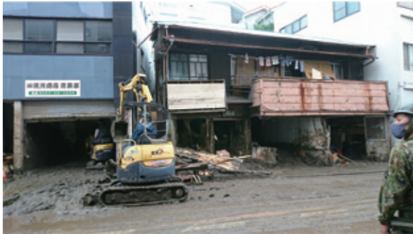
写真-6 土石流による家屋内土砂撤去の状況
