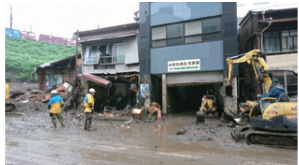
写真-5 土石流による家屋内土砂撤去の状況
