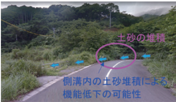
写真-16 土石流源頭部上流開発に伴う盛土内への流入 7)
