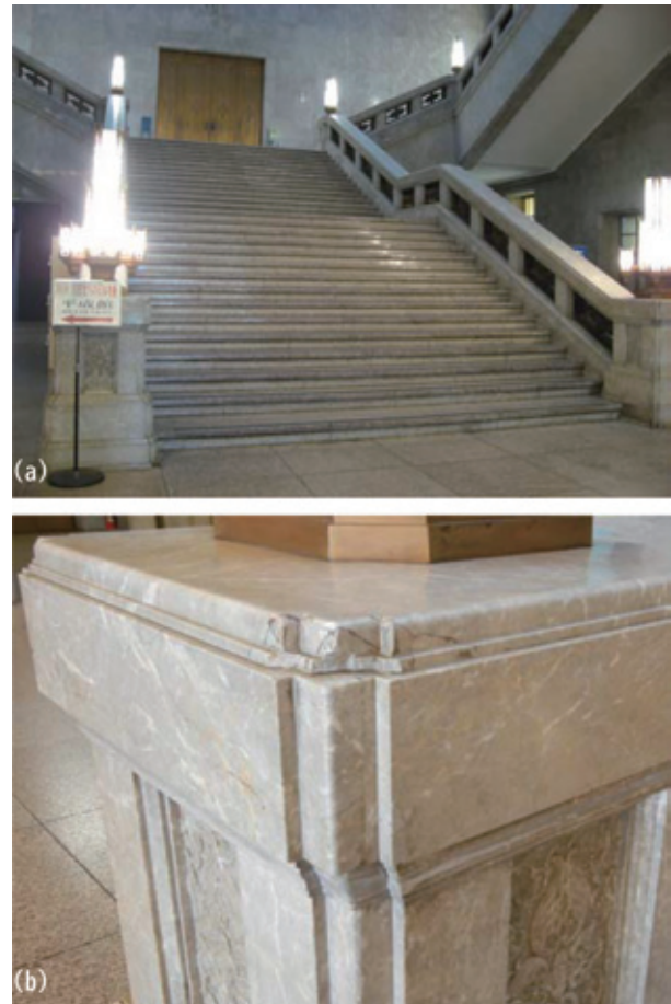
図1 東京国立博物館のエントランスホール。(a) 大階段と吹き抜けの大ホールに全面的に阿南市の大理石「茶竜紋」が貼られている。2008年撮影。(b) 石材の色は黄味がかった灰色の時に白い脈と黄色い筋が入る。2011年撮影。
