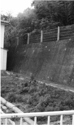
写真8 東川原石町8番地の 施工済みの擁壁 (近隣住民撮影)
