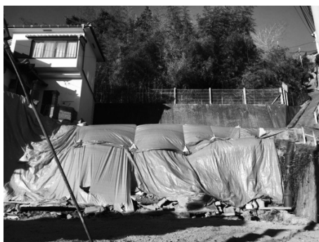
写真7 2018年12月撮影の災害発生現場写真（筆者撮影）
