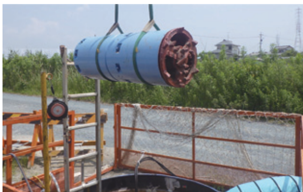
写真-1 掘進機設置状況
