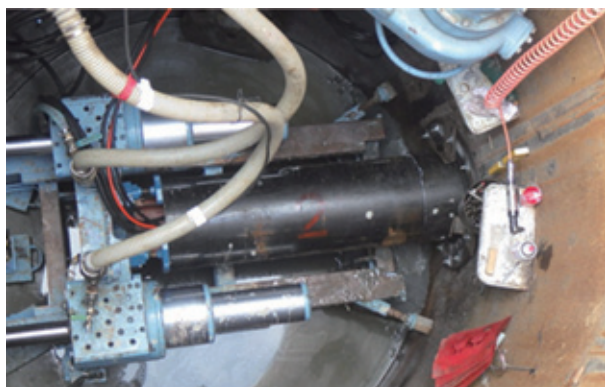
写真-2 推進用鋼管接続
