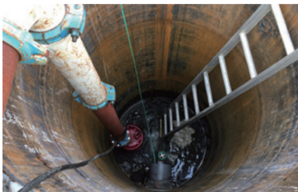
写真-5 集排水状況
