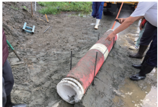
写真-9 MPDパイプ洗浄状況
