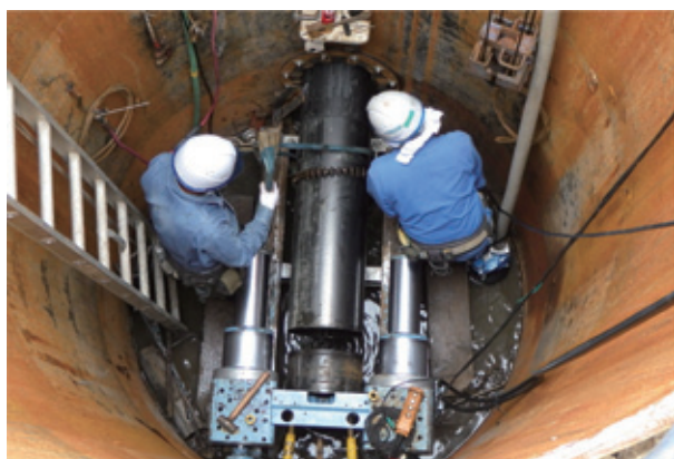
写真-4 鋼管引抜き
