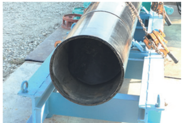
写真-8 掘進機格納完了
