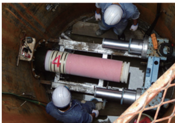
写真-3 集排水パイプ挿入
