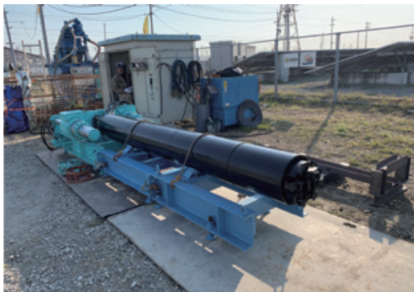
写真-6 リターン型掘進機
