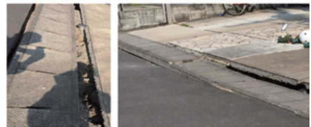
(b) 側溝の開き・沈下
