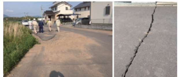
(a) 道路の噴砂・亀裂
