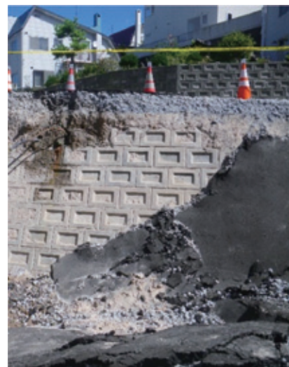
写真-4 造成時に埋め殺しにした擁壁
