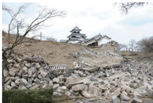
写真-1 東日本大震災で崩落した小峰城跡の石垣
