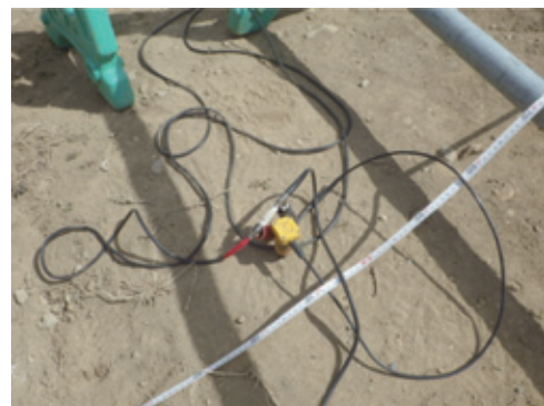
写真-3 弾性波探査測定状況
