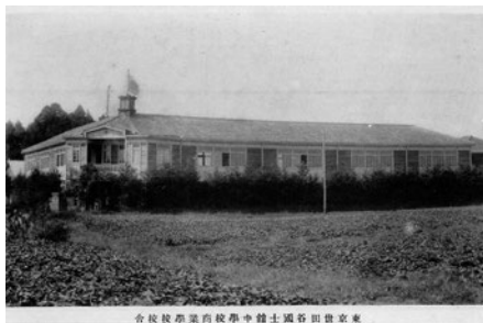
写真4 大正15年頃 国土館中学校・商業学校校舎（東側）
