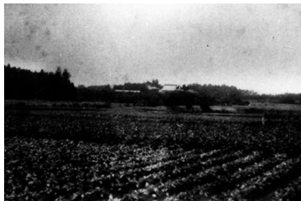
写真1 大正8年頃 北東から国土館を望む
