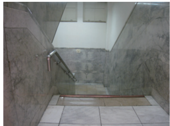
図11 階段の手すりや腰壁が山口県産の「薄雲」と思われる。白く細粒で緻密な大理石で、青灰色の模様がある。階段の段石のベージュ色の石は山口県産の「霞」の可能性はある。
