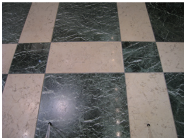
図4 中央ホールの床の市松模様。濃緑の部分が埼玉県皆野町産の蛇紋岩「貴蛇紋」である。ベージュ色はイタリア産大理石「ペルリーノ・ロザート」。
