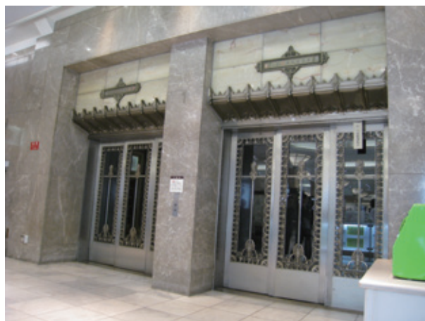
図6 北西側エレベーターの1階部分（北面側）の枠。徳島県産の「時鳥」と考えられる。エレベーター扉上の白い部分はおそらく外国産のオニックスである。
