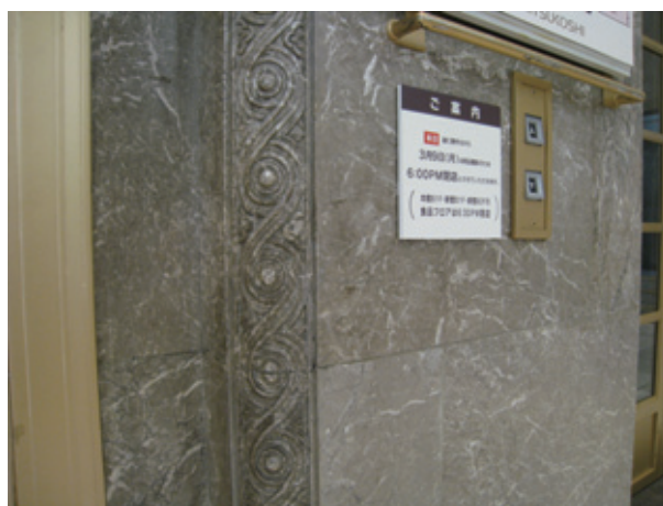
図7 北西側エレベーターの1階部分（西面側）の枠。徳島県産の「時鳥」または、多少濃い褐色なので徳島県産「茶竜紋」の可能性もある。
