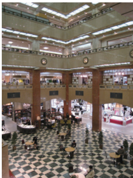
図1 中央ホール。5階まで吹き抜けの大空間である。床の市松模様のベージュ色はイタリア産大理石「ベルリーノ・ロザート」、濃緑は埼玉県産蛇紋岩「貴蛇紋」、柱の赤色はフランス産大理石「ルージュ・ドゥ・ヴィトロール」である。3階以上の高欄の後ろに見える柱は山口県産「白鷹」である。
