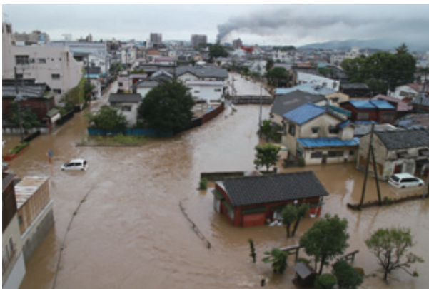
写真8 栃木市中心部の浸水被害状況(9日午前6時頃)
