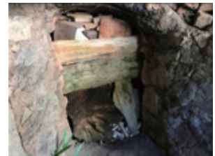
図3 木材の敷き詰め
