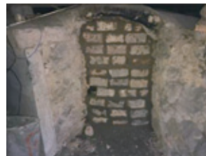
図4 炭窯木材投入口の密閉
