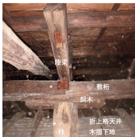
写真14 身舎の軸部（中央丸柱柱頭部）
