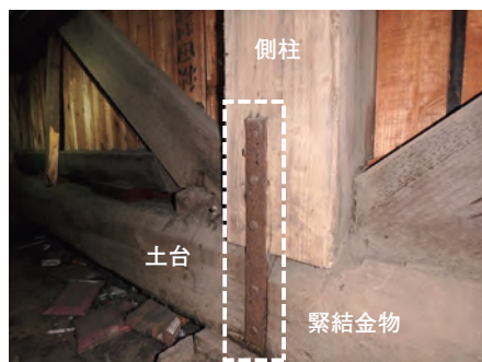
写真10 側柱・土台緊結金物
