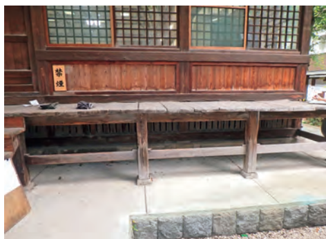
写真 74 現状 濡れ縁 束・貫の削れ
