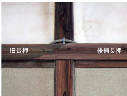
写真 72 現状 長押継手
