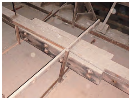
写真 19 陸梁の継手部分
