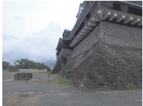
(a) 南西面の石垣 (Z2断面付近)
