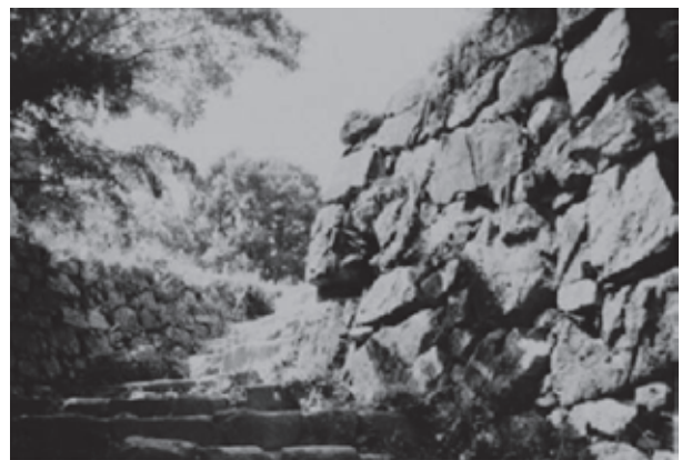
写真-4 穴太工法例（安土城） 8)
