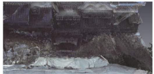
(b) 石垣崩壊部正面図
