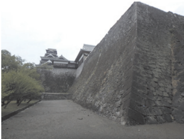
写真-13 二様の石垣：B1, B2断面付近
