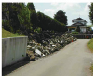
(h) 空石積擁壁の崩壊 (西原町)
