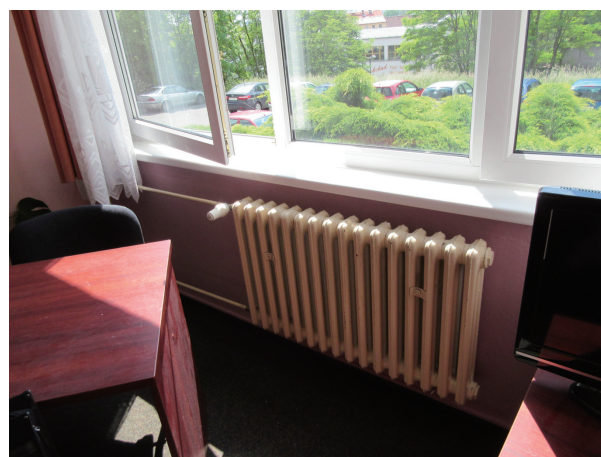
ラジエターには、天然ガス焼きボイラーで造られる温水が循環している。
