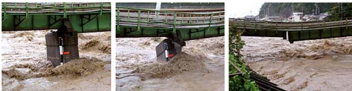
図 3.2.37 H橋梁 1P の倒壊状況
