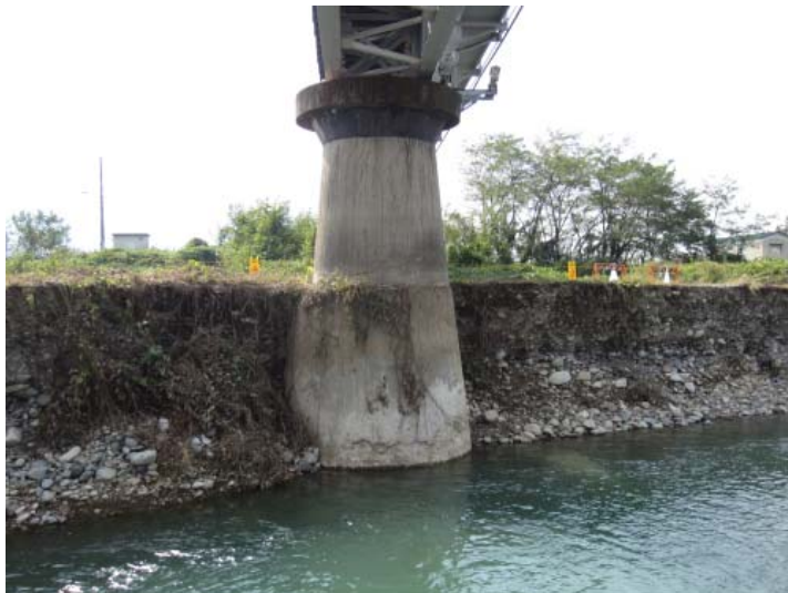
図 3.2.28 F 橋梁 4P の被災状況
