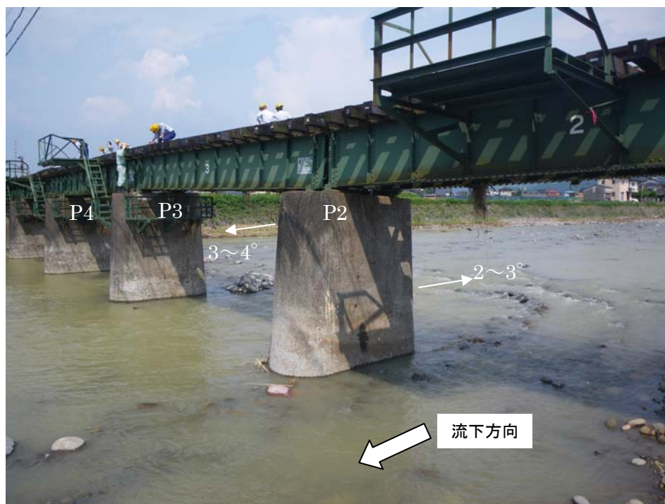
図 3. 2. 41 被災した橋脚の状況
