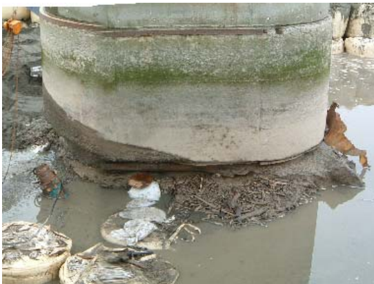
b) 19P 基礎の洗掘状況
